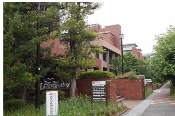
図1 レンガ造りの基礎系研究棟
