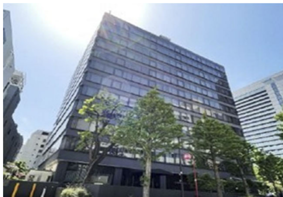
写真1 本社所在のビル外観
